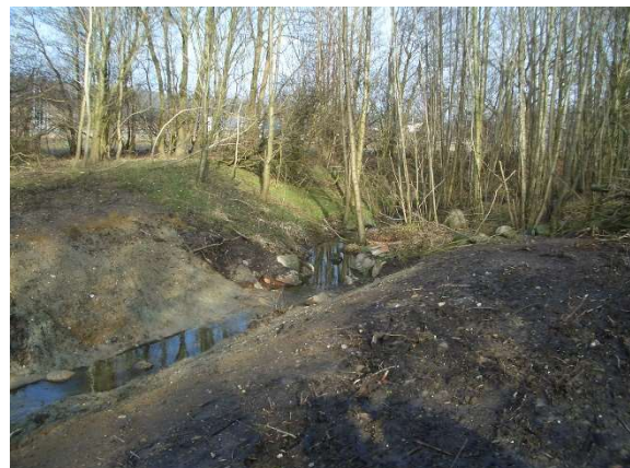
Abb. 33: Auslauf vorh. RRB/ Schulendammgraben
