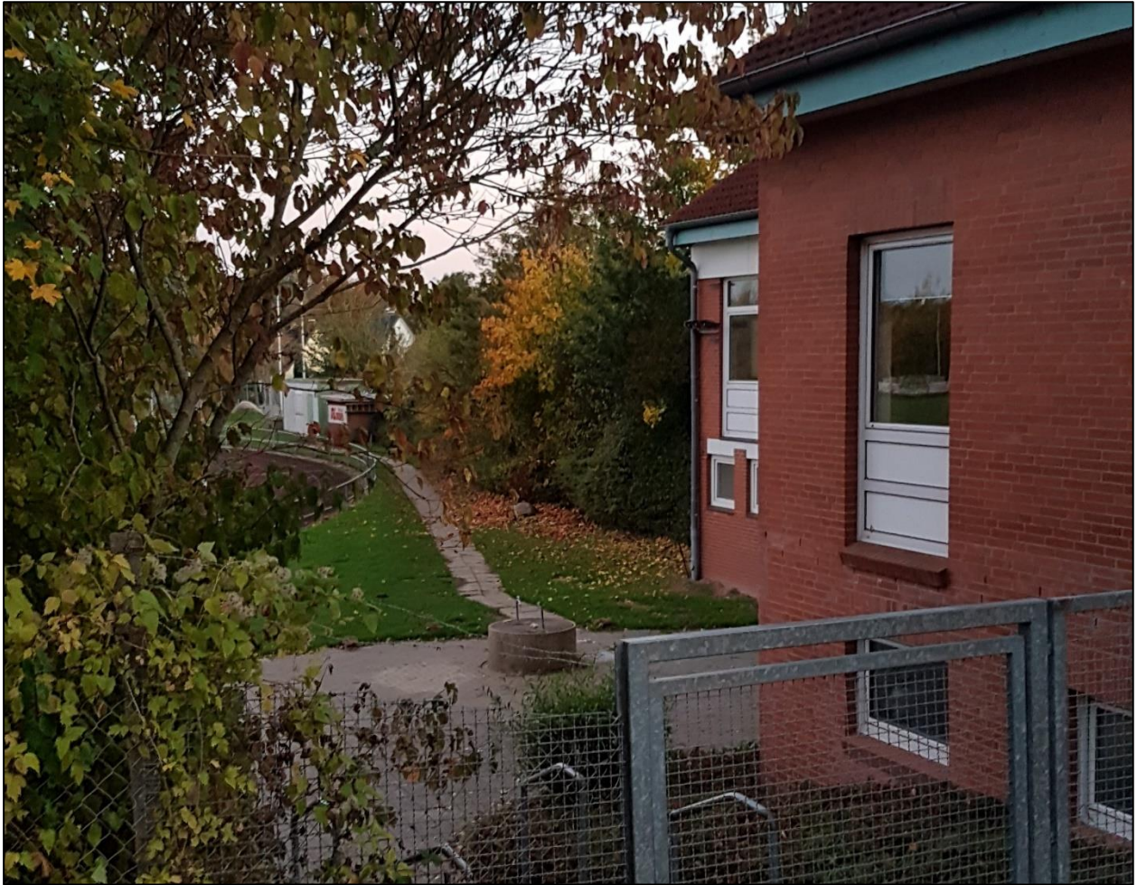
Abbildung 5: Durchgang am Bestandsgebäude zum Sportplatz vom Parkplatz aus
