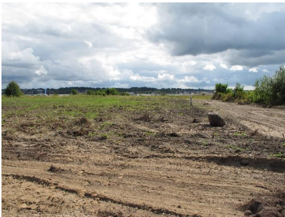
Foto 1: Blick auf teilweise bereits beräumte Flächen im Norden am 21.08.2019 (Blickrichtung Süd).
