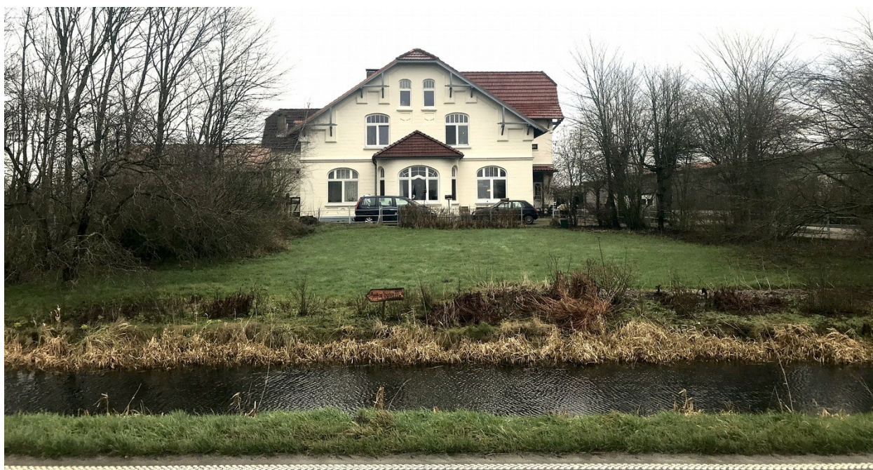
Abb. 1: Blick von der Landesstraße 149 auf das 1907 erbaute Haupthaus der Hofstelle Heim
