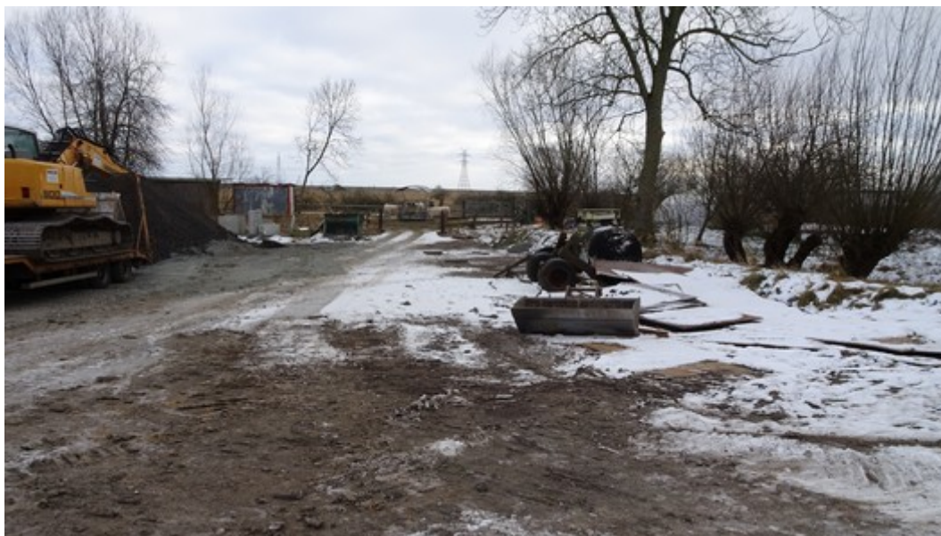
Abb. 16: Blick auf die Freilagerfläche, auf der die Werkstatt errichtet werden soll
