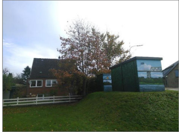
Foto 4: Blick auf die östliche Plangebietsgrenze und die bestehenden Nachbarbebauung ‚Kieler Straße 49‘ sowie die Trafostation der Schleswig-Holstein Netz AG (05.11.2020).
