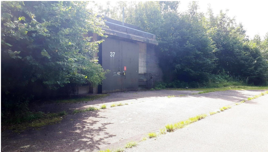
Abb. 6: Blick auf einen geschlossenen Bunk des Typs 200 mit schwerem Schiebetor und versiegeltem Vorplatz. (Foto: C. Grave)
