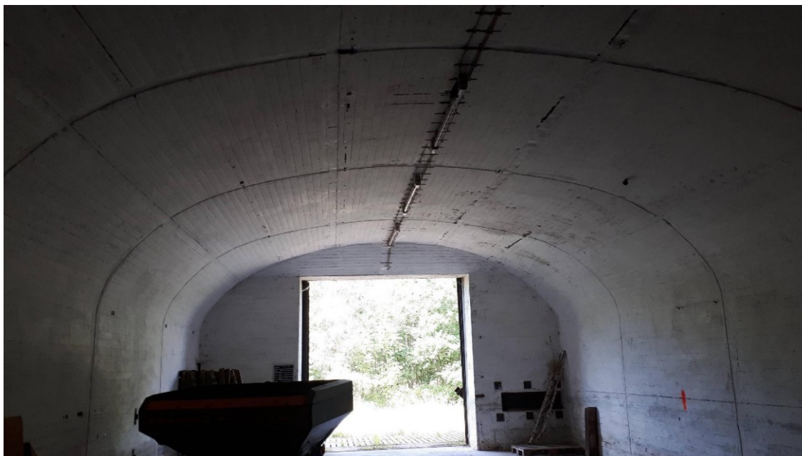
Abb. 5: Blick von innen Richtung Tor, rechts neben dem Tor sind Einlassungen in der Mauer, die ehemals mit Technik bestückt waren, oben ist die Lichtleiste zu sehen. (Foto: C. Grave)
