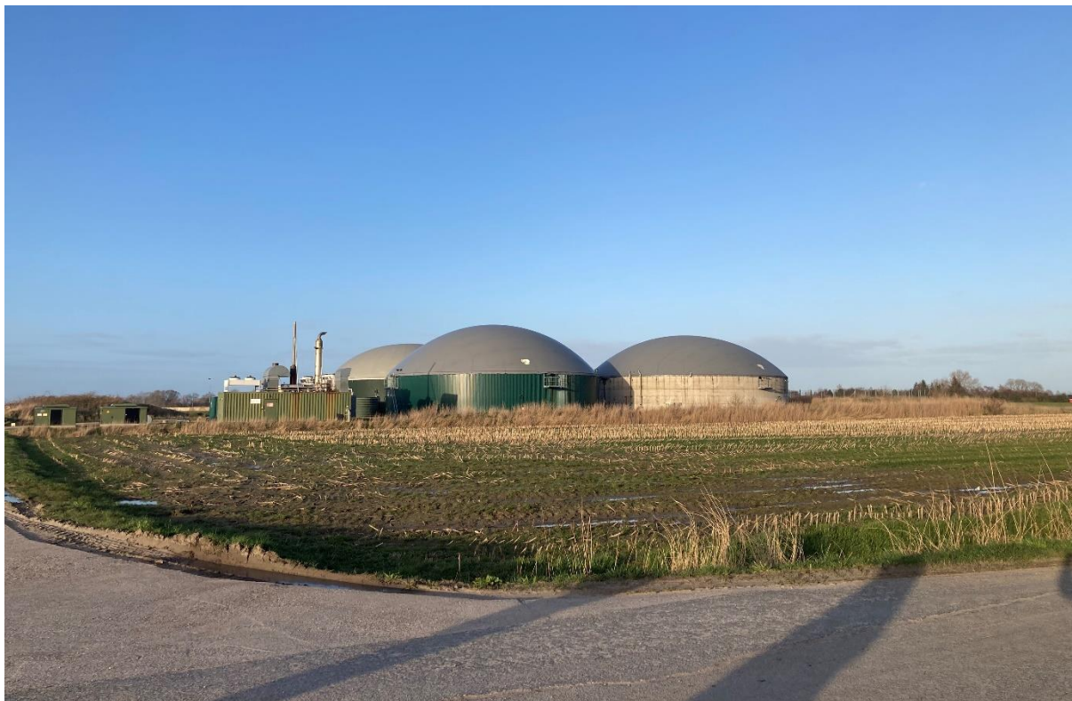
Abbildung 7: Blick auf die Biogasanlage aus Süden, Elbberg 2023
