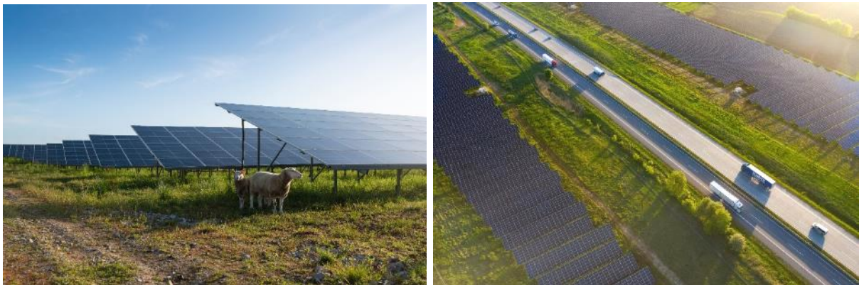
Abbildung 4: Beispiele für Module einer F-PVA derselben Vorhabenträgerin in Schönbek (Amt Bordesholm) (Quelle: Enerparc AG, Hamburg)
