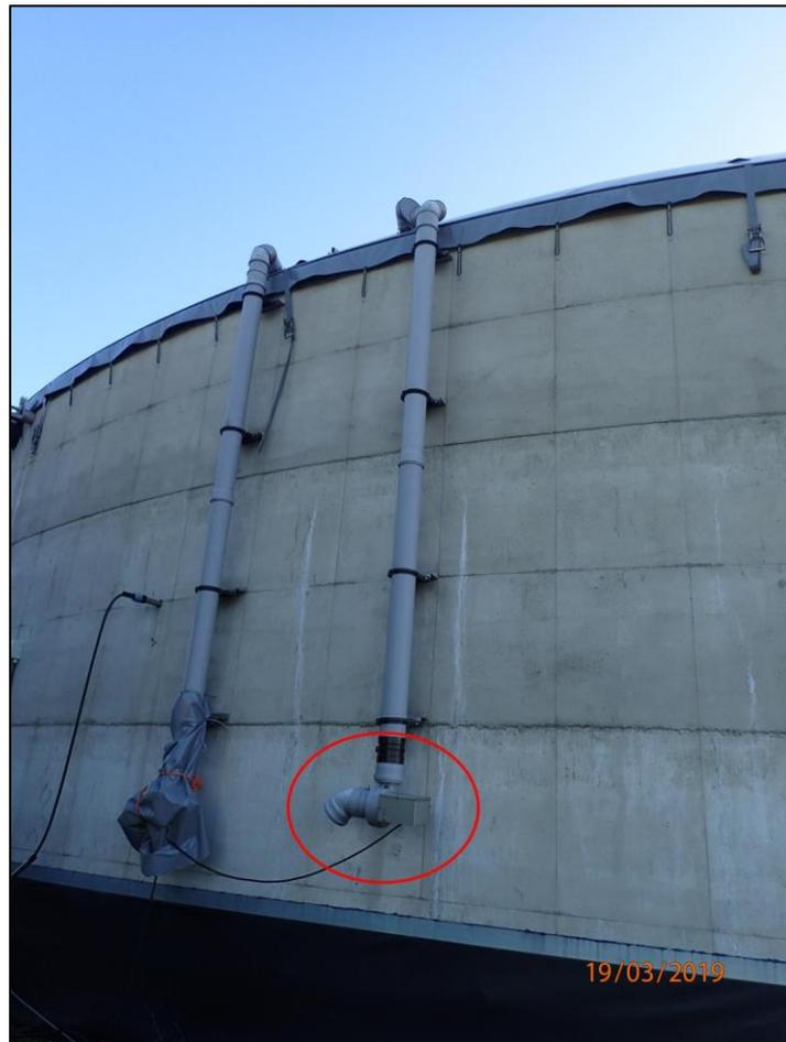
Abbildung 5: Stützluftgebläse Gärrestlager
