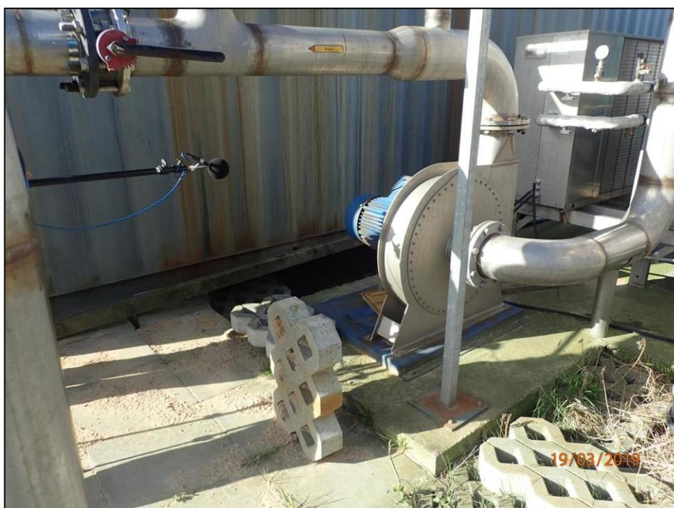
Abbildung 7: Biogas-Verdichter
