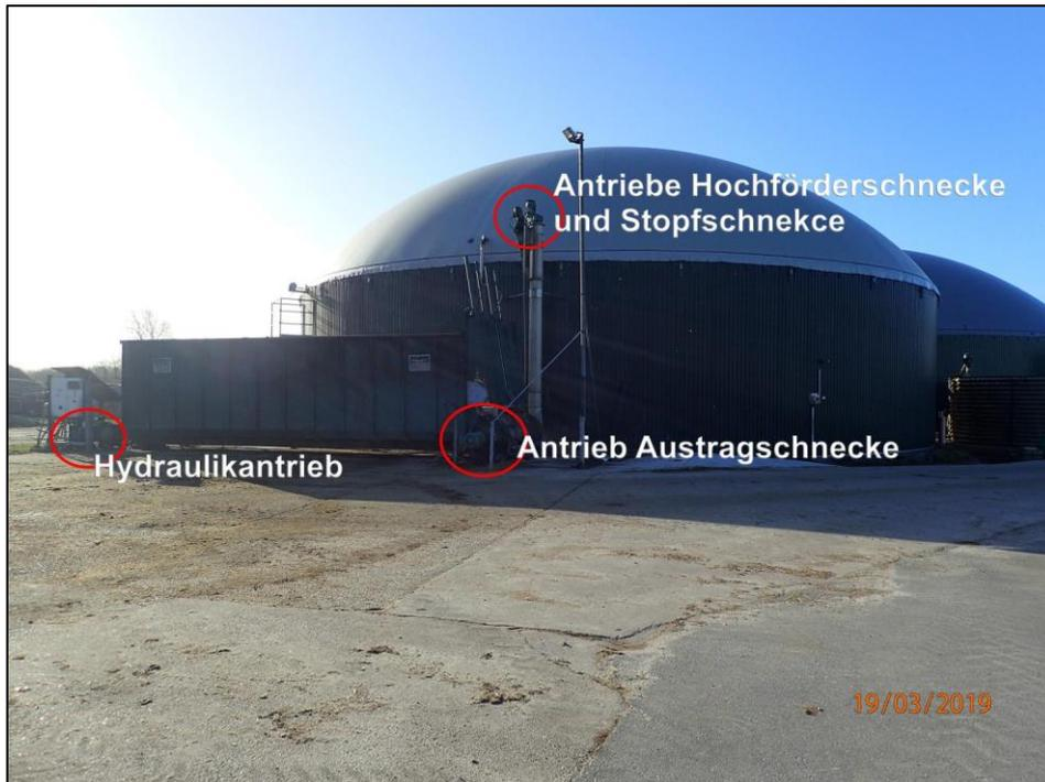
Abbildung 2: Feststoffdosierer
