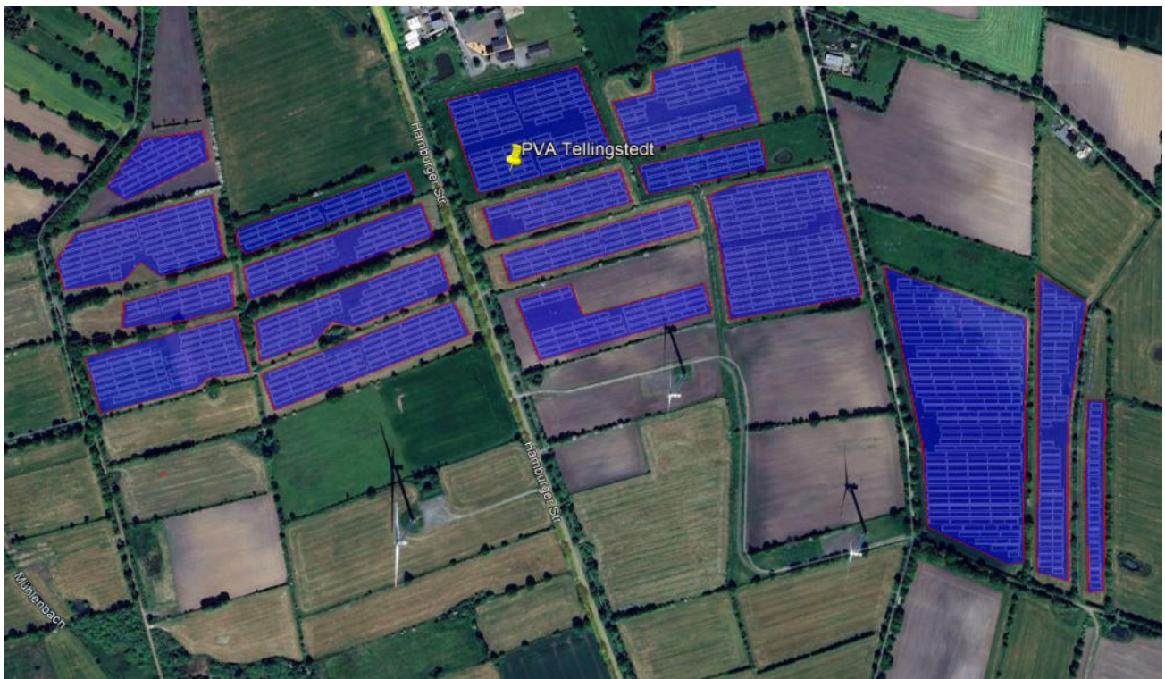
Bild 2.1.3: Detailansicht der PV-Fläche (Quelle: Google Earth/SolPEG)
