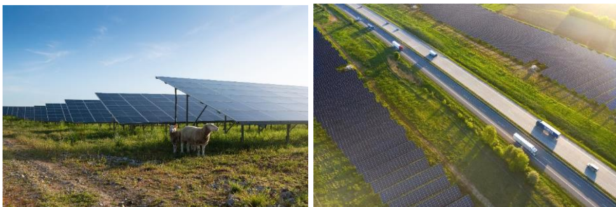
Abbildung 4: Beispiele für Module einer F-PVA derselben Vorhabenträgerin in Schönbek (Amt Bordesholm) (Quelle: Enerparc AG, Hamburg)
