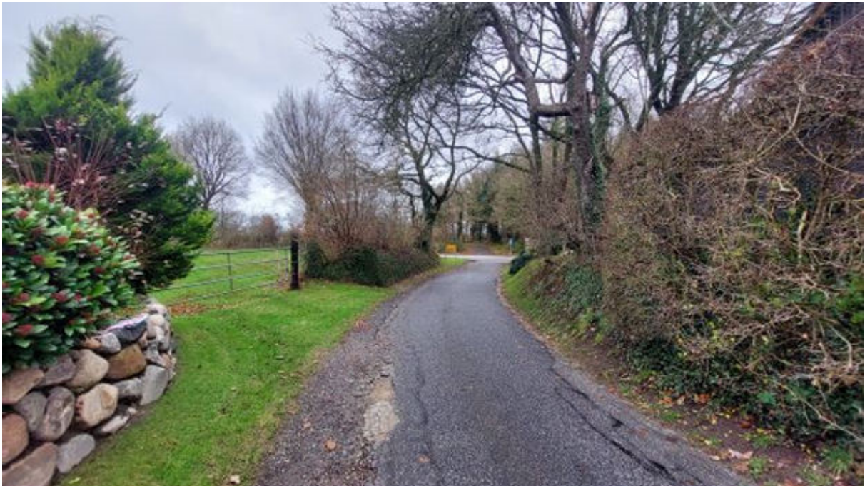
Fläche 1: linksseitig hinter Hecker Alternativstandort; Blickrichtung zur B 203; Straßenbreite Mühlenweg 3,30 m bis 3,50 m, teilweise schlechter Zustand (Sanierungsbedarf auf ca. 25 m zwischen Ausfahrt Fläche Nr. 7 bis B 203); beidseitige Böschung
