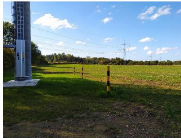
Fläche 2: Blickrichtung Südwesten (Richtung Autobahn, im Hintergrund)
