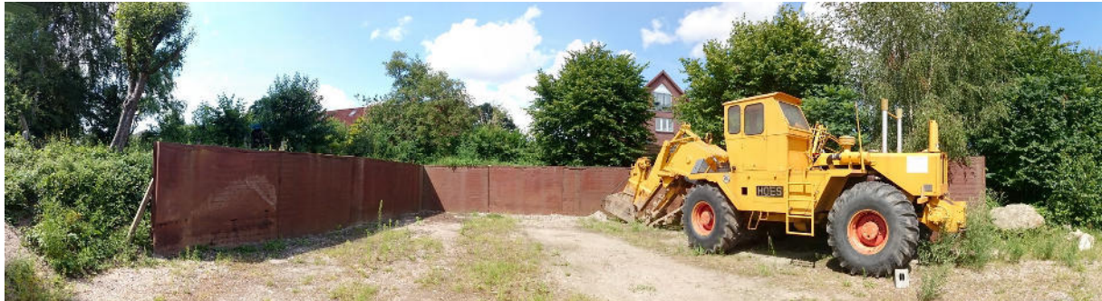
Blick vom nordöstlichen Hofbereich in Richtung Nord mit Radfräse Hoes
