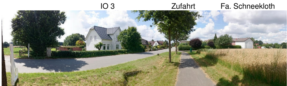
K 66 Blickrichtung West auf Zufahrtbereich Fa. Schneekloth
