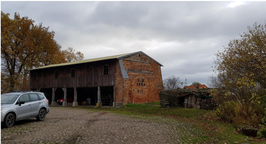
Abb. 28: Heute steht neben der Restmauer nur noch der Mittelteil des ehemaligen Stall- und Scheunengebäudes (Foto: Büro für Bauleitplanung)
