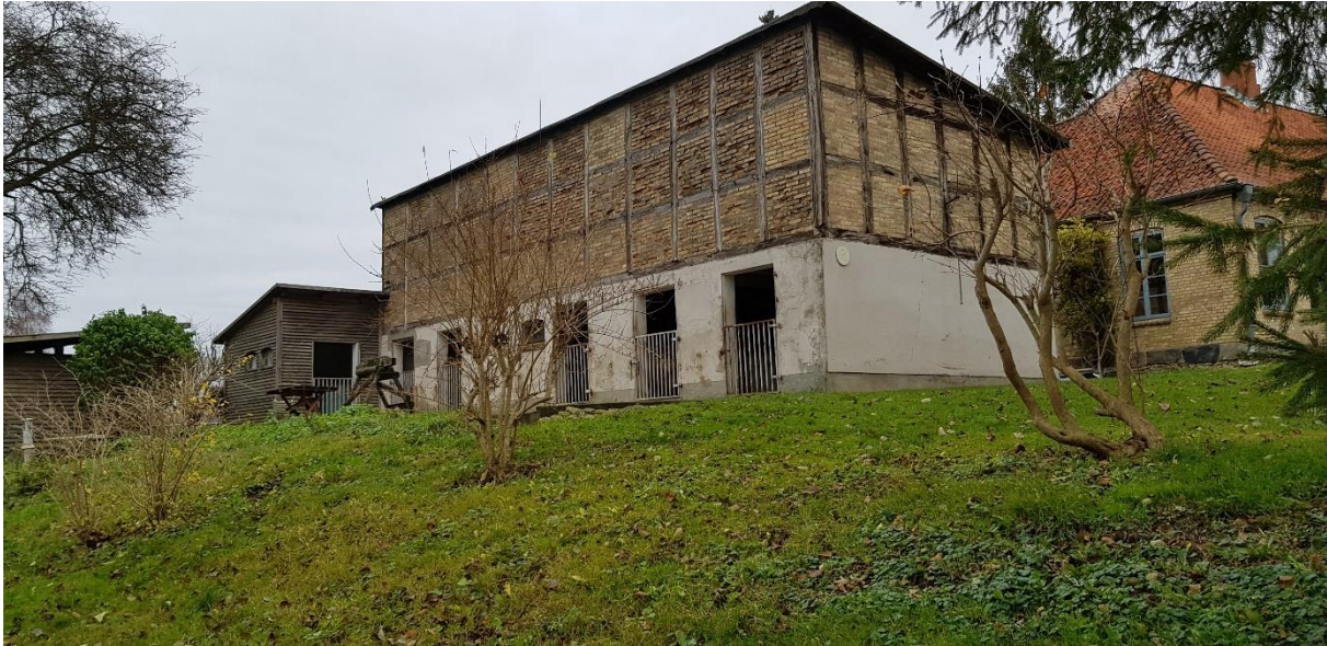
Abb. 39: Pferdestall der Therapiepferde (Quelle: Büro für Bauleitplanung)
