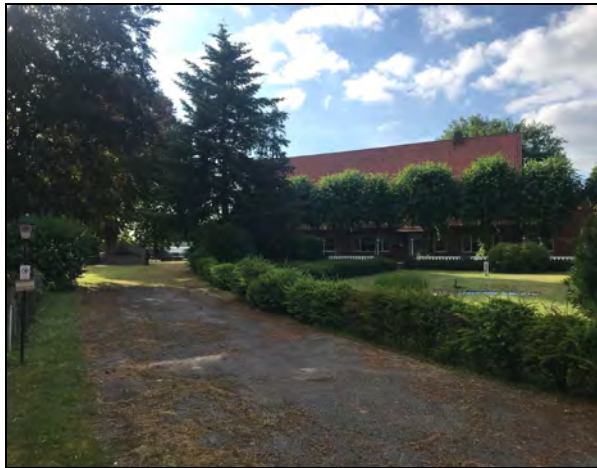
Abbildung 6: Ehemalige Zufahrt zum Gasthof vom Ellerwiesenweg
