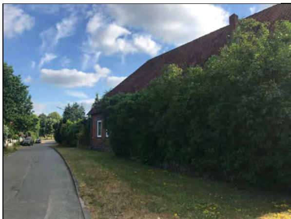
Abbildung 8: Traufseite des Bestandsgebäudes von Osten am Ellerwiesenweg
