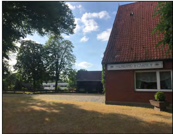
Abbildung 7: Gasthofgebäude von Süden
