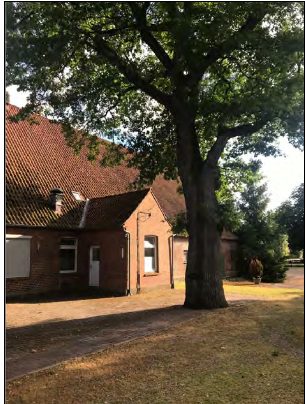
Abbildung 11: Nebeneingang an der Nordseite mit prägender alter Eiche
