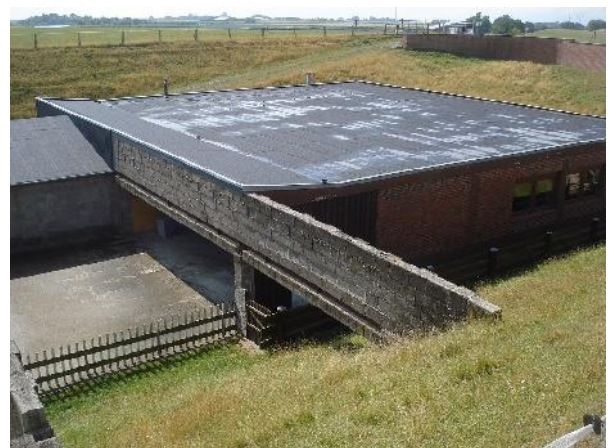
Abb. 8b Blick auf den eingemauerten Bereich der Schießanlage im Norden der durch Wälle geschützten Anlage
