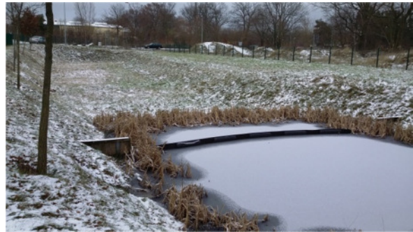
Foto 5: Regenrückhaltebecken im Bereich eines ehemaligen extensiv genutzten Parkplatzes
