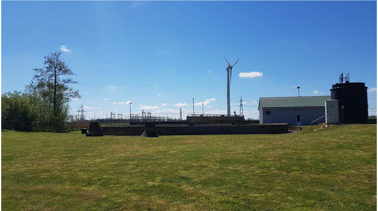
Abbildung A2.1 Blick vom Eingangsbereich über das Gelände der Kläranlage.
