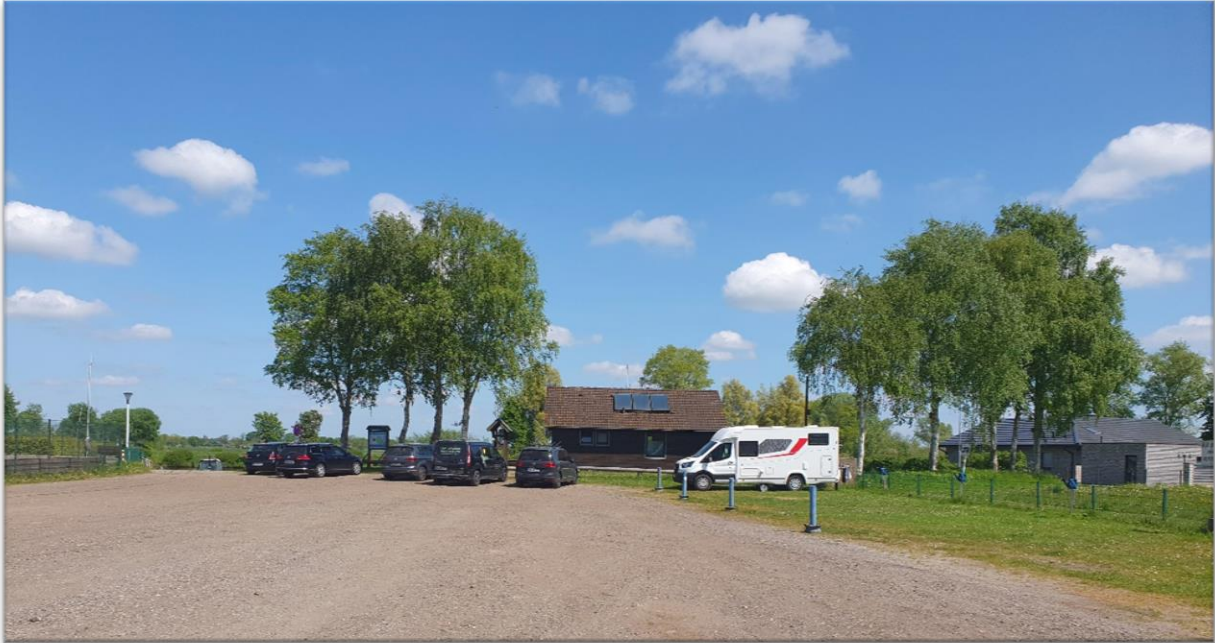
Foto 1: Blick auf den bisherigen Wohnmobilstellplatz und das Hafengebäude
