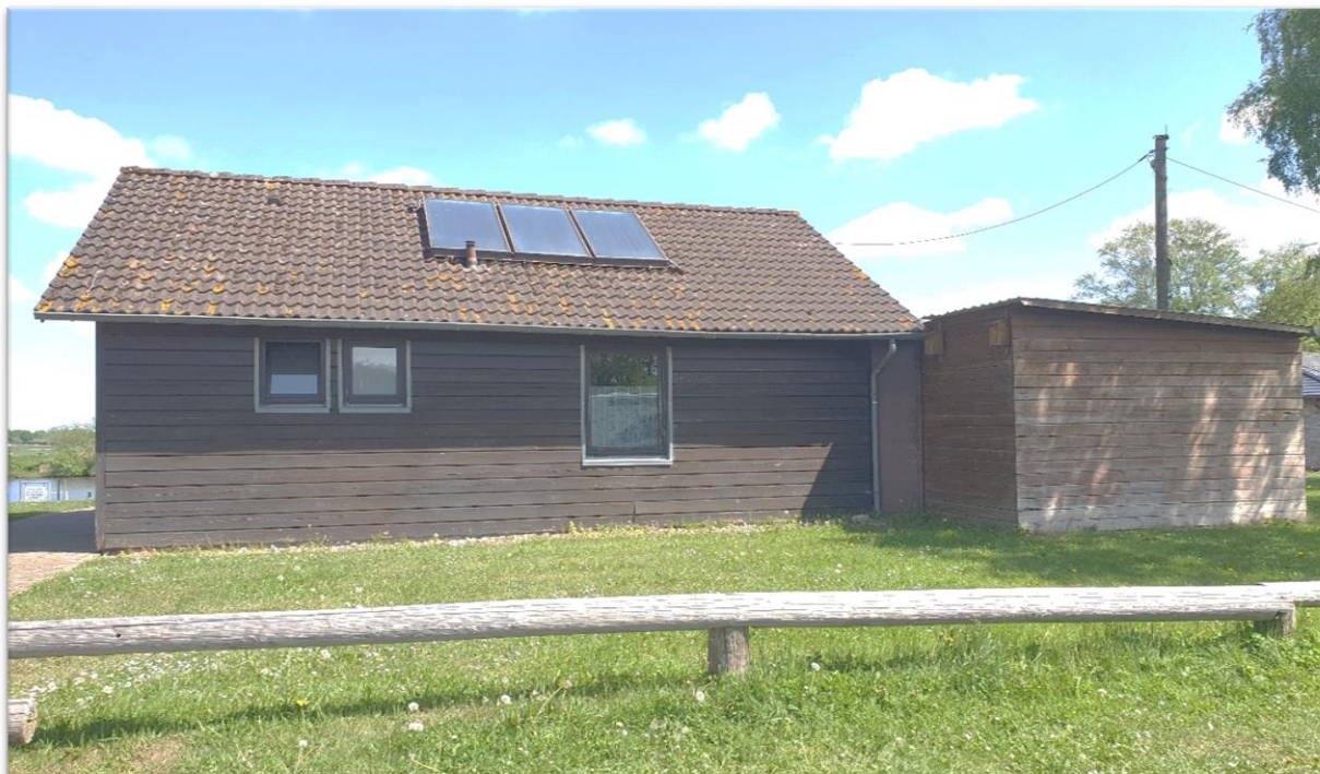
Foto 3: Hafengebäude mit Nistkästen am Anbau (rechts im Bild)
