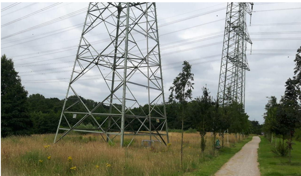
Abbildung 23: Zustand der Fläche im Juli 2021 (Foto: Gemeinde Oststeinbek)
