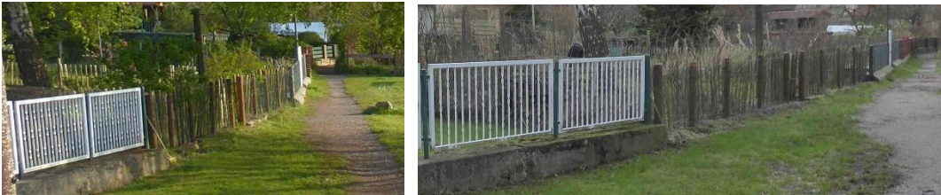
Abb. 7: Einfriedungen entlang des Spazierwegs
