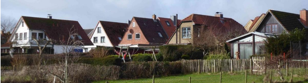
Abb. 6: Ansicht rückwärtige Bebauung – südöstlich Lange Straße
