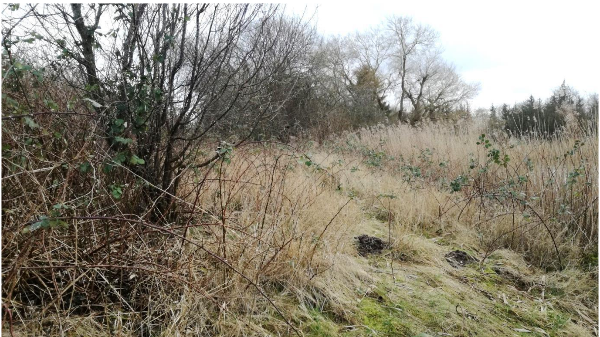
Abb. 21: Böschung an der Bahnlinie vor dem Ufer
