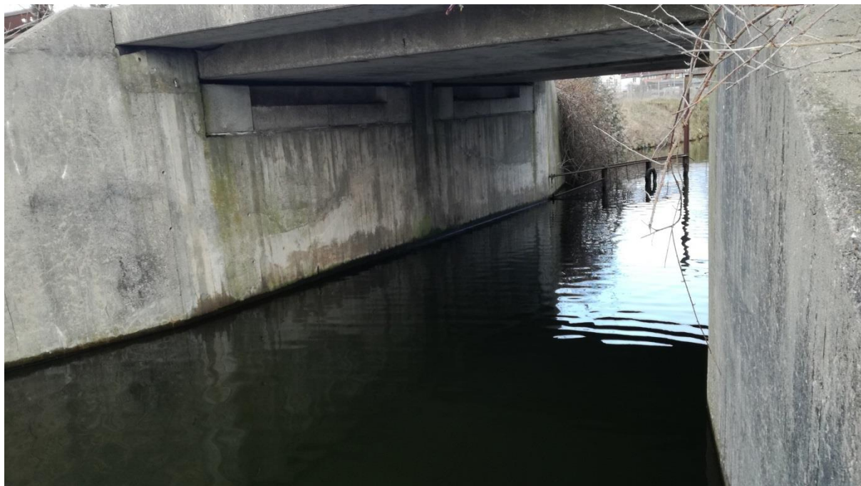
Abb. 22: Durchlass unter der Bahn im Nordosten, geplante Fußwegeverbindung
