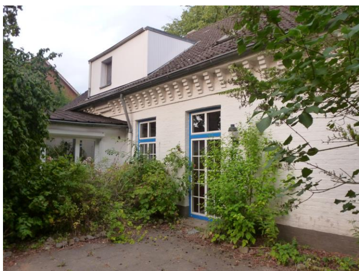
O.Grell. 04.08.18. Haus Teilansicht
