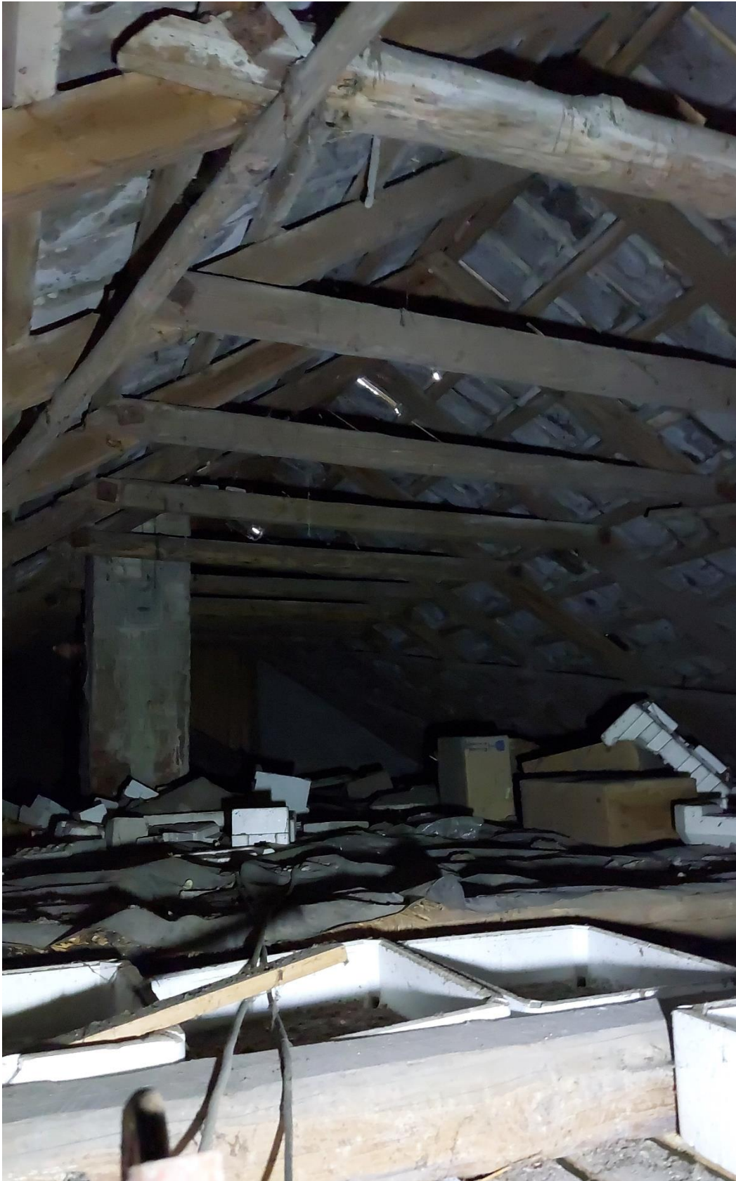
Abb. 2.4 Dachraum der Scheune (Foto: S. Bock; 11.04.2024).
