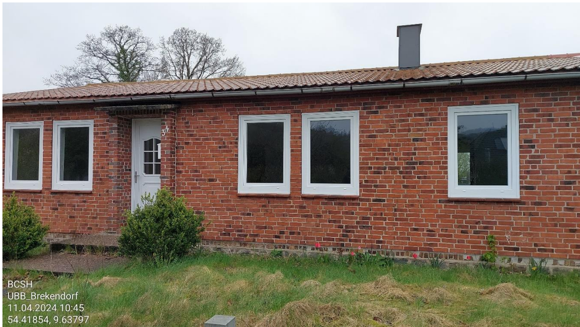
Abb. 2.1 Ansicht auf die betroffene Doppelhaushälfte (Foto: S. Bock; 11.04.2024).
