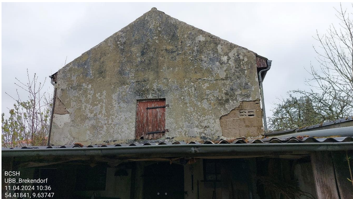
Abb. 2.2 Blick auf die Scheune sowie das Dach des angeschlossenen Carports (Foto: S. Bock; 11.04.2024).
