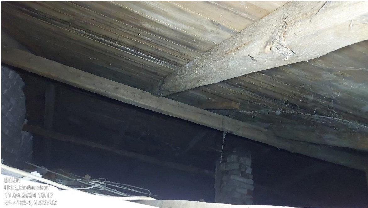
Abb. 2.3 Blick in den Dachraum des Wohngebäudes (Foto: S. Bock; 11.04.2024).
