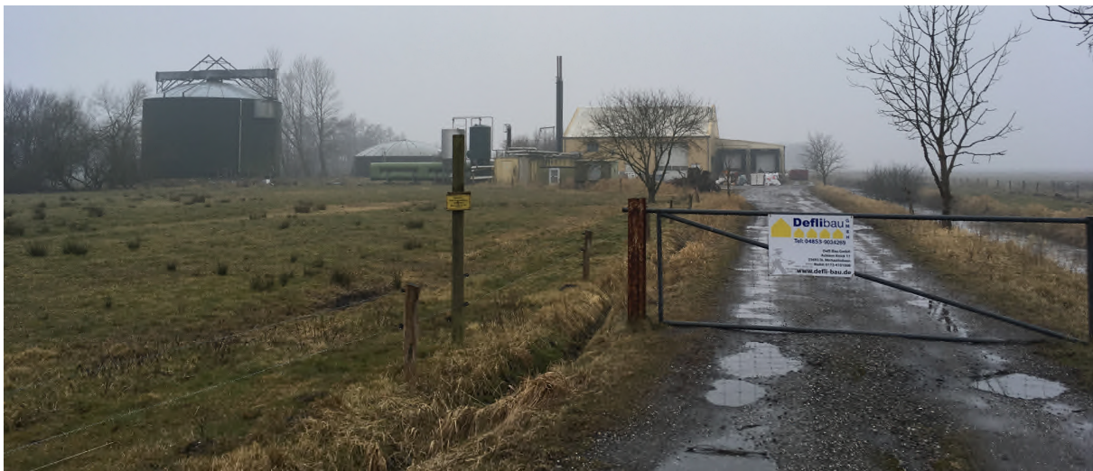
Bild 4 Blick Richtung Westen über das Betriebsgelände der stillgelegten Biogasanlage.
