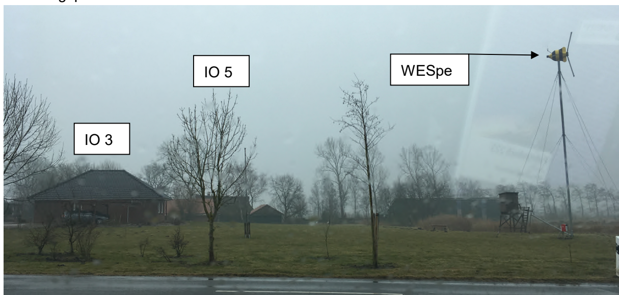
Bild 3 Blick in südlicher Richtung auf die Wohnbebauung am Ortsrand von St. Michaelisdonn
