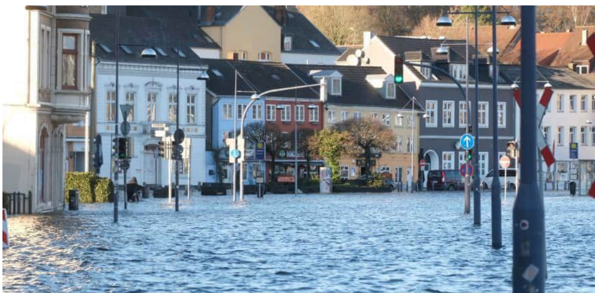
Abbildung 53: Hochwasserereignis in Flensburg am 02.01.2019 (shz 2019, Foto: Sebastian Iwersen)
