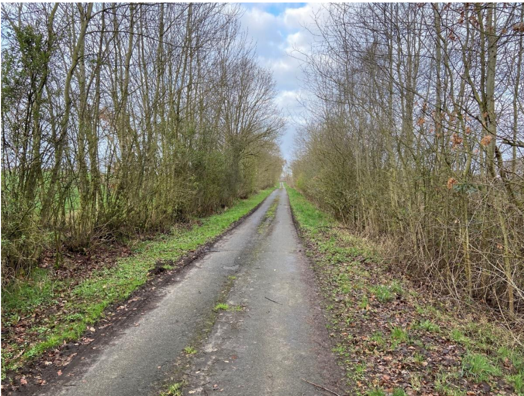
Foto 9: Asphaltierter Feldweg nördlich des Geltungsbereichs mit beidseitigem Knick. Blickrichtung Südwesten.
