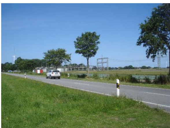
Abb. 3f Blick vom Knotenpunkt „Dr. Meyer-Str. / Helserdieker Strot“ auf die K 20 im Bereich des Vorhabengebiets
