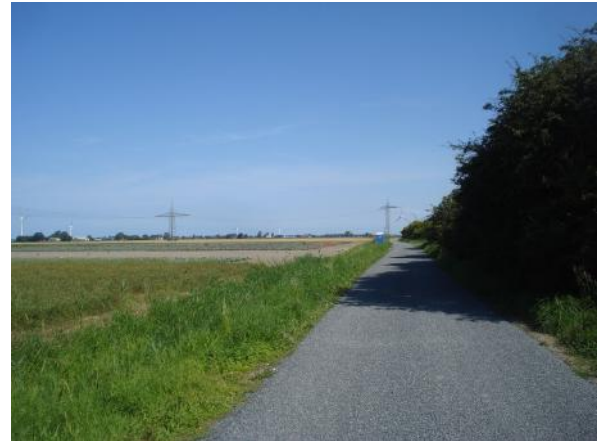
Abb. 3k Ausbaurzustand des Gemeindeweges „Helserdeichsland“
