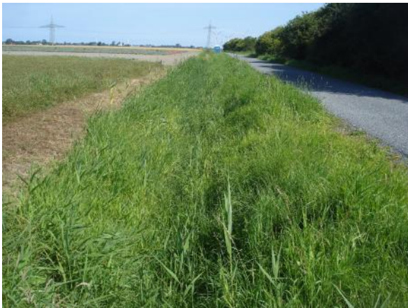
Abb. 3l Straßenseitengraben auf der westlichen Seite des Gemeindeweges „Helserdeichsland“
