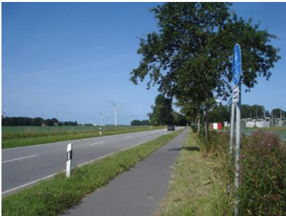
Abb. 3f Blick von der Einmündung des Gemeindewegs „Helserdeichsland“ in die K 20 mit Blick nach Westen (Umspannwerk)
