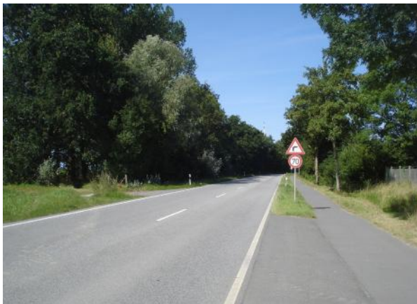
Abb. 3p Anbaufreie Strecke an der K 20 in Höhe der Umspannwerke Helse Diekerströt I / II mit Blick nach Westen
