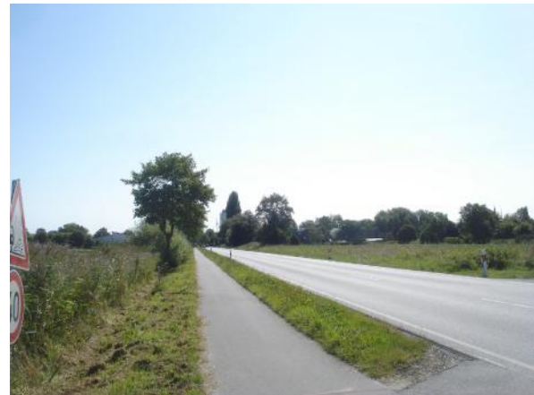
Abb. 3g Blick von der Einmündung des Gemeindewegs „Helserdeichsland“ in die K 20 mit Blick nach Osten (Stadttrand von Marne)
