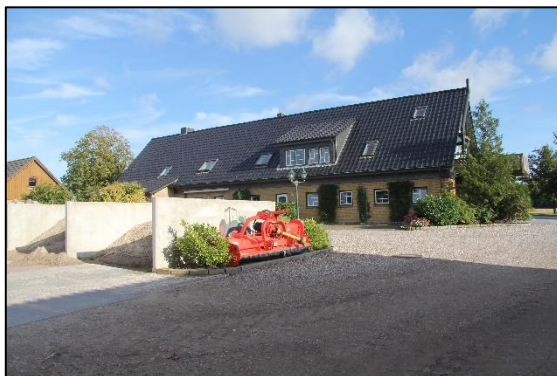
Wohngebäude Ansicht Nord
