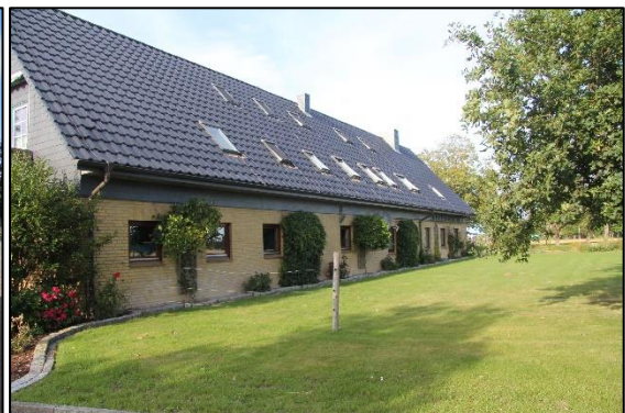
Wohngebäude Ansicht Süd
