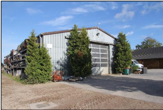
Maschinenhalle Ansicht Ost
