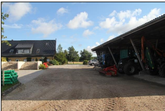
Maschinenhalle im westlichen Bereich
