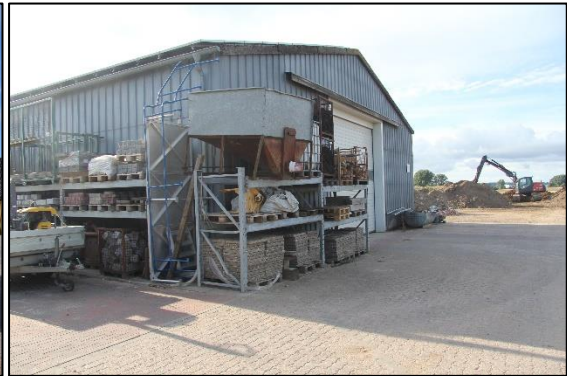
Maschinenhalle Ansicht West mit Lagerregal
