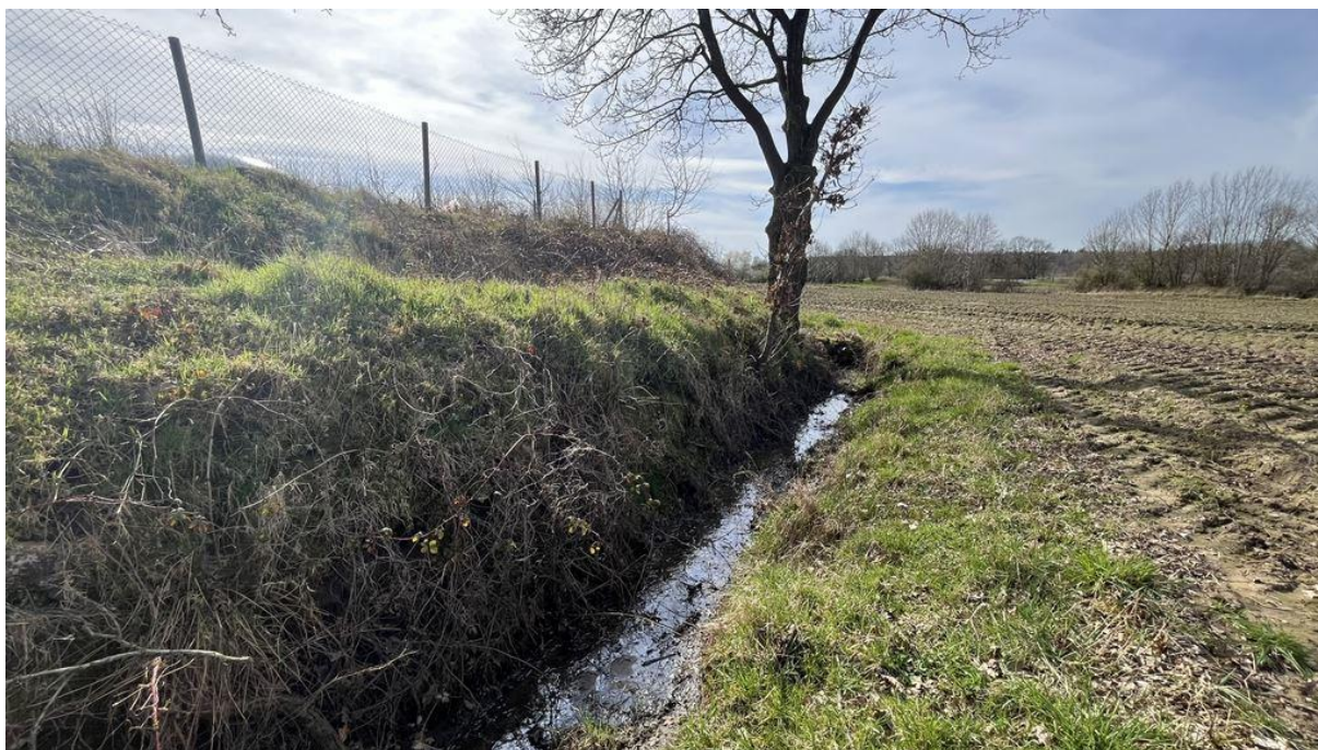
Abbildung 16: Entwässerungsgraben nördlich des Speicherbeckens, Elbberg 2024.
