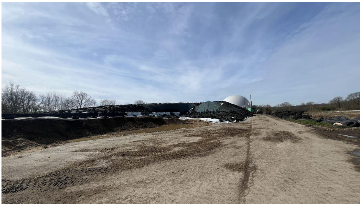
Abbildung 10: Blick auf die Biogasanlage aus Osten, Elbberg 2024.
