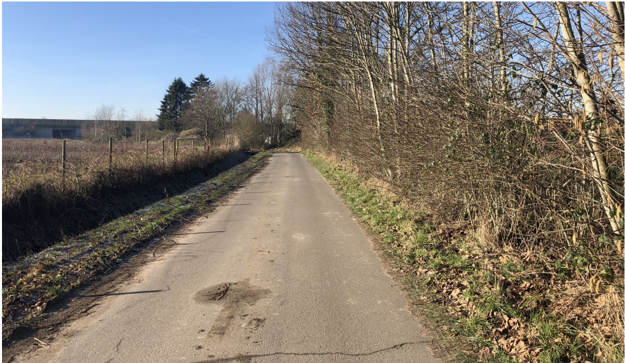
Abb. 7: Knick zwischen der Gemeindestraße Hainholz und dem Teilgeltungsbereich 2
