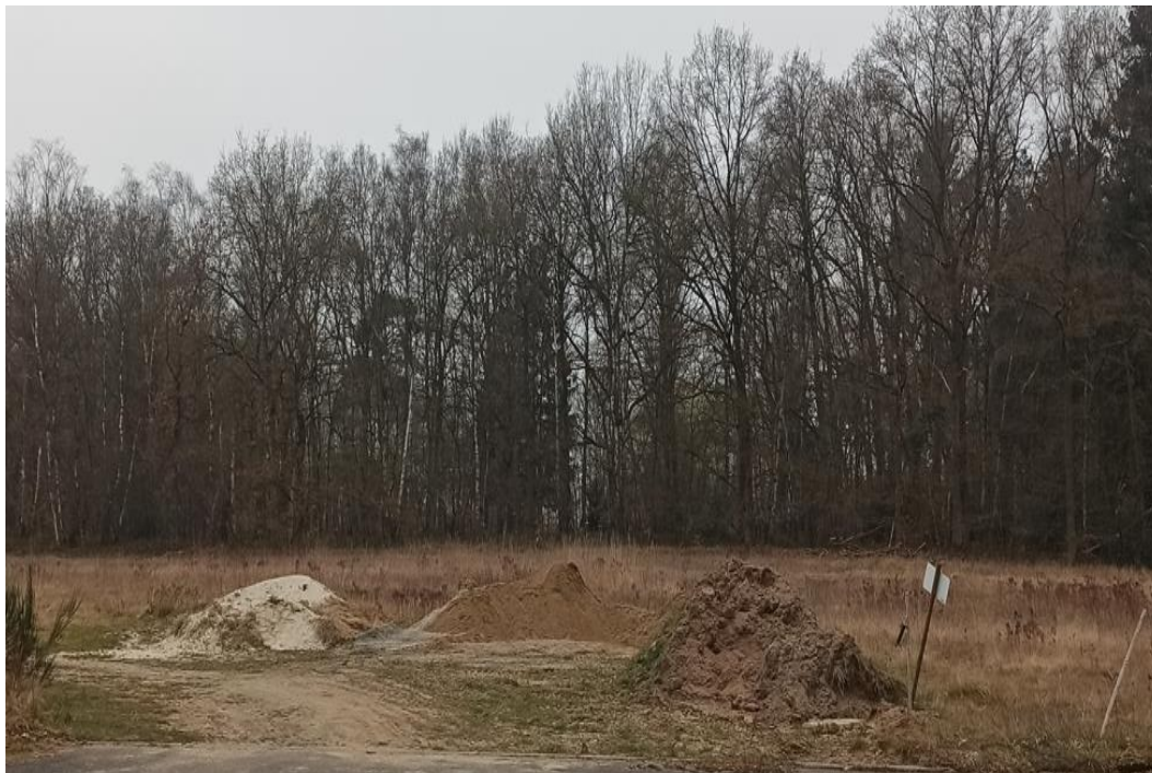
Foto 6: Materiallager von Sand und Mutterboden.
