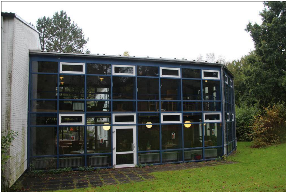
Abbildung 4: Verbindungsbau zwischen Westflügel und übrigen Gebäudebestand (Abbruch vorgesehen)
