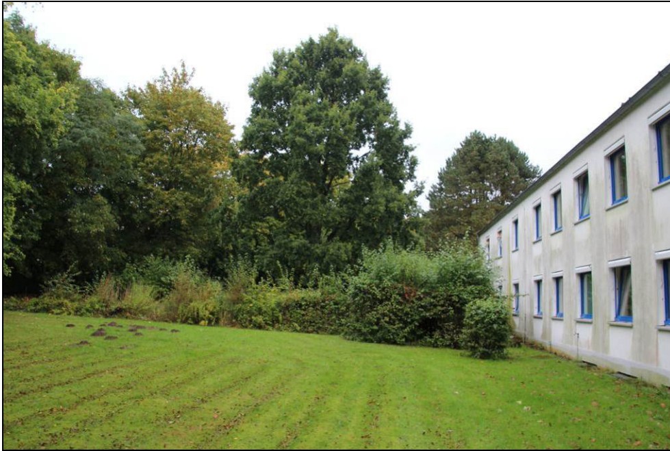
Abbildung 3: zum Abbruch vorgesehener Westflügel mit Freiflächen und Gehölzen, auf denen der Neubau vorgesehen ist. Die Stieleiche im Hintergrund wird erhalten
