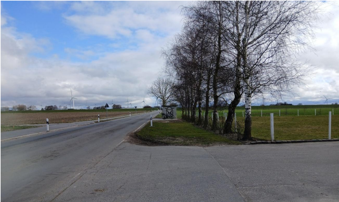
Abbildung 24: Vollversiegelte Verkehrsfläche (Norderstraße, SVs), Blickrichtung Ost
