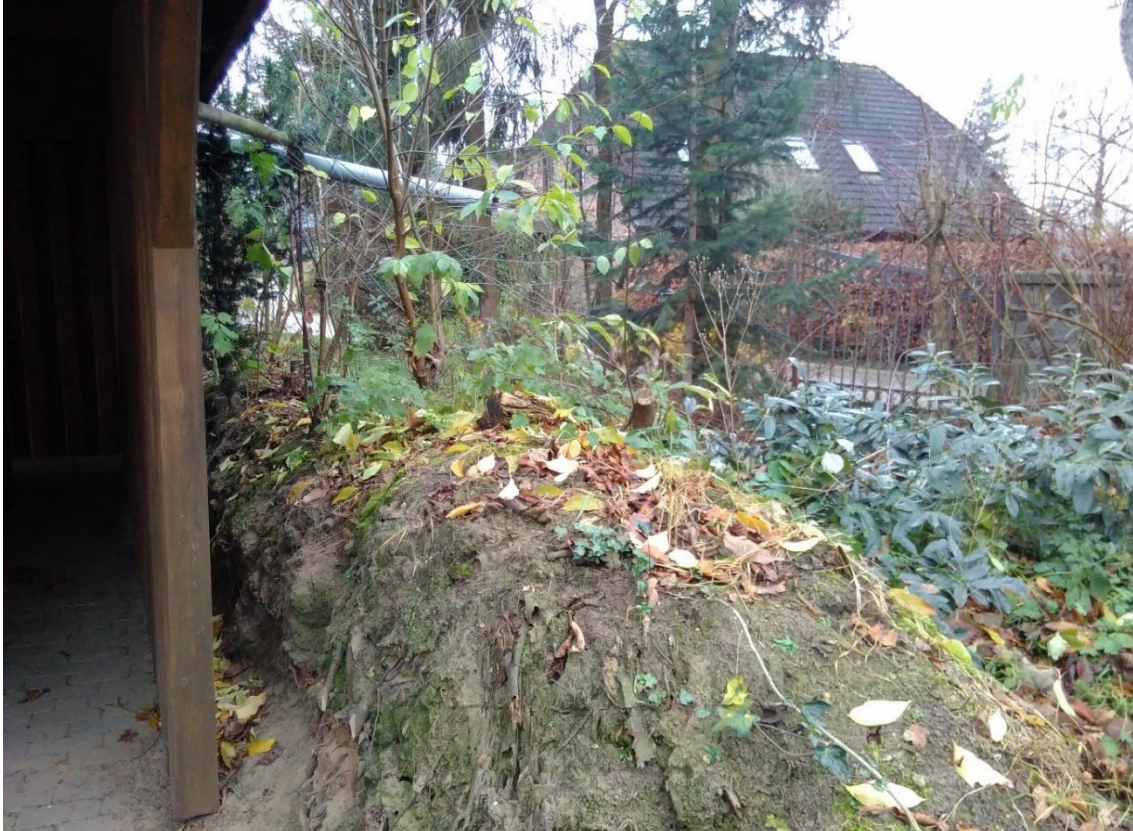
Abb. 21: Degenerierter Knick mit Eingriffen im Knickschutzstreifen Nähe Dorfstraße, Quelle: TGP
