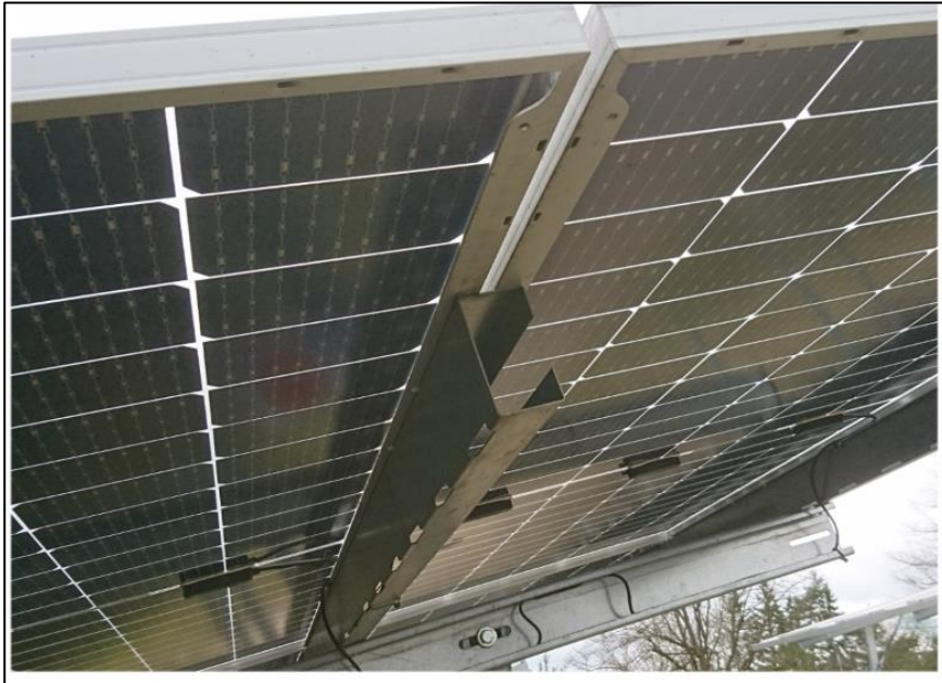
Abbildung 18: patentiertes Regenwasserverteilsystem von SUNfarming (Foto: SUNfarming 2024)
