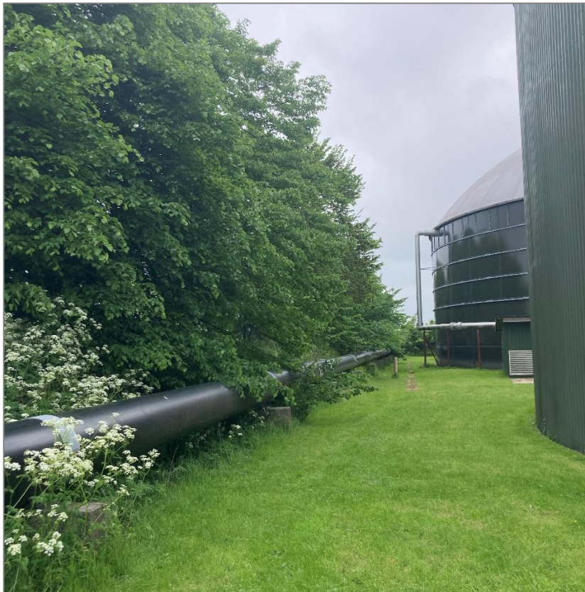
Foto 3: Links Knick an der Grenze des Plangebiets, rechts Biogasanlagen, Blickrichtung Norden (eigene Aufnahme vom 24.05.2023)
