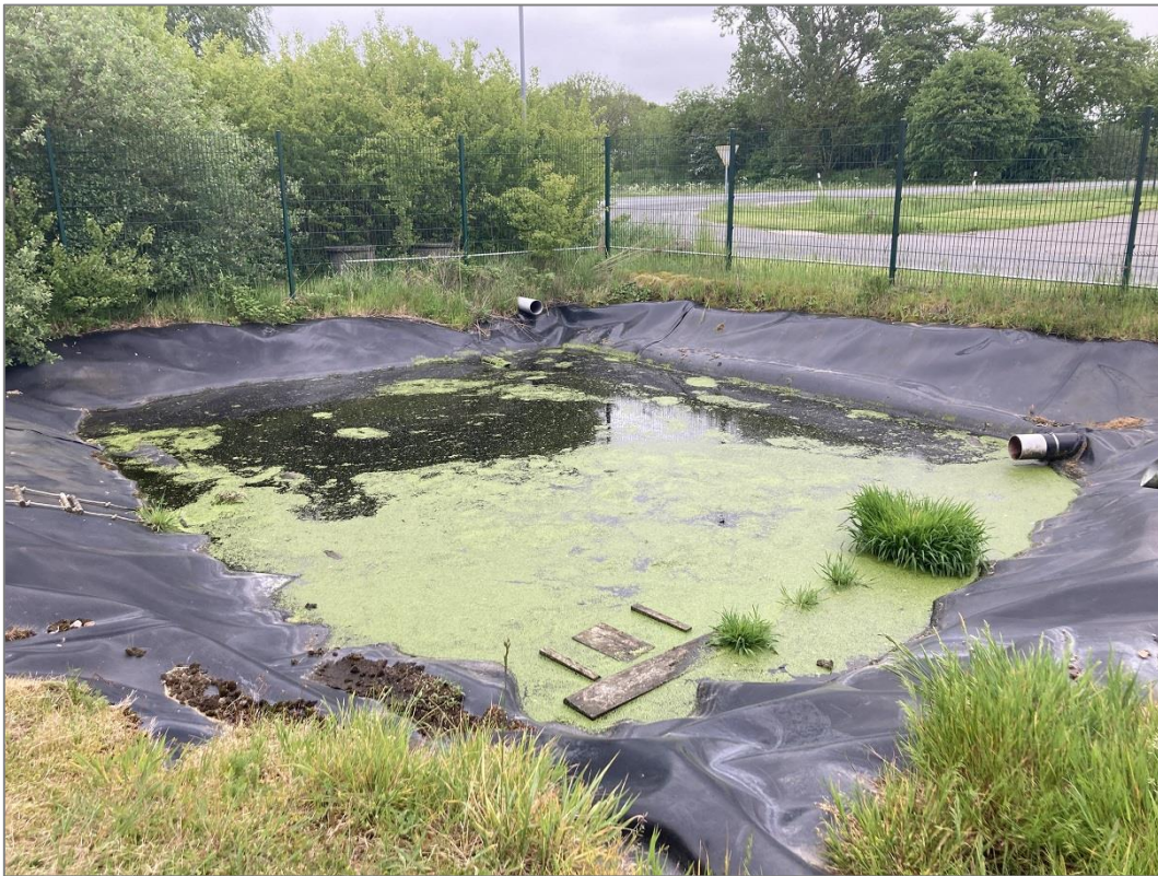
Foto 5: Sonstiges künstliches Foliengewässer (Regenrückhaltebecken), Blickrichtung Südost (eigene Aufnahme vom 24.05.2023)
