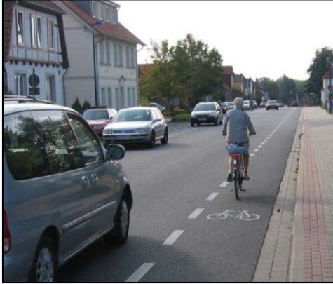
Abbildung 31: Beispiel eines Radschutzstreifens (NLSV, 2007).
