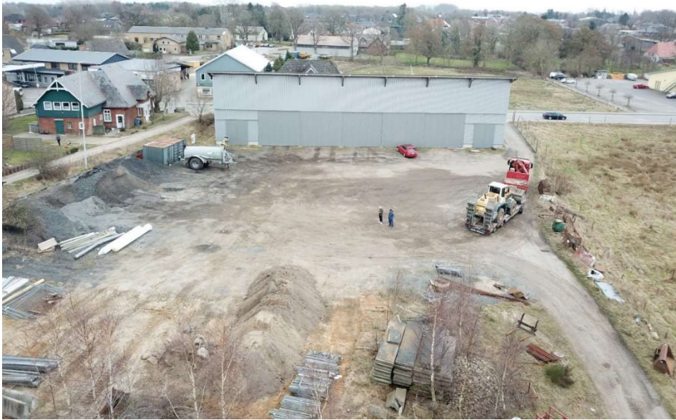
Bild 1 Blick Richtung Südosten über das zur Erweiterung vorgesehene Betriebsgelände, TG 1, Aufnahme vom 04.03.2021
