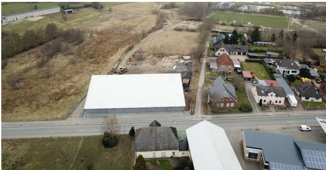
Bild 2 Blick Richtung Nordwesten über den nördlichen Teil des Betriebsgeländes mit der Erweiterungsfläche sowie den östlich angrenzenden Wohngebäuden, Aufnahme vom 04.03.2021
