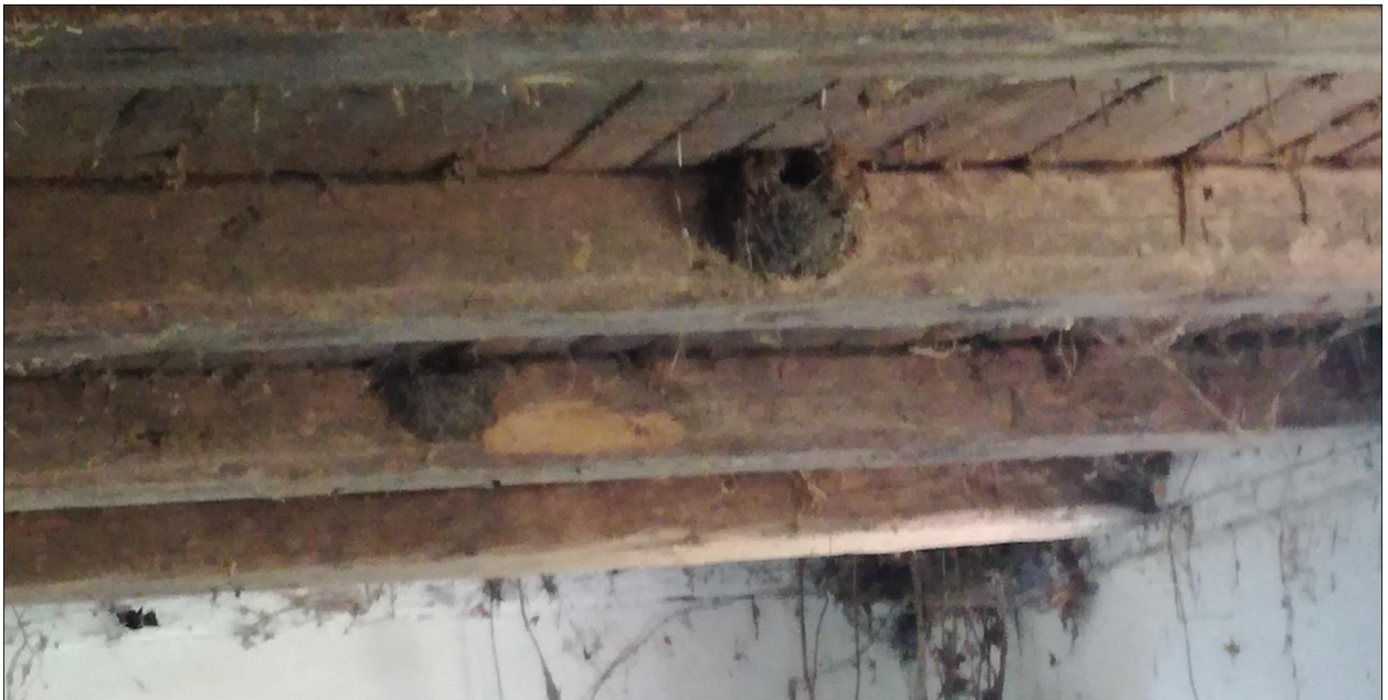
Ältere Rauchschnalbenester im ehem. Schweinestall
