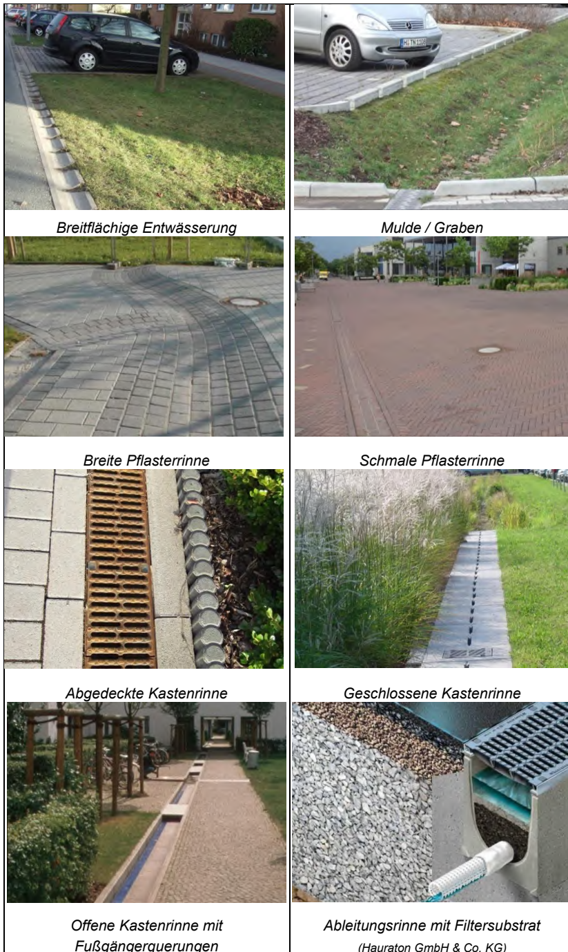
Abbildung 2-3: Beispiele oberirdischer Ableitungssysteme
