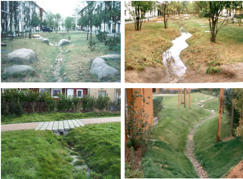
Abbildung 4-1: Beispiele für die oberflächennahe Ableitung von Regenabflüssen
