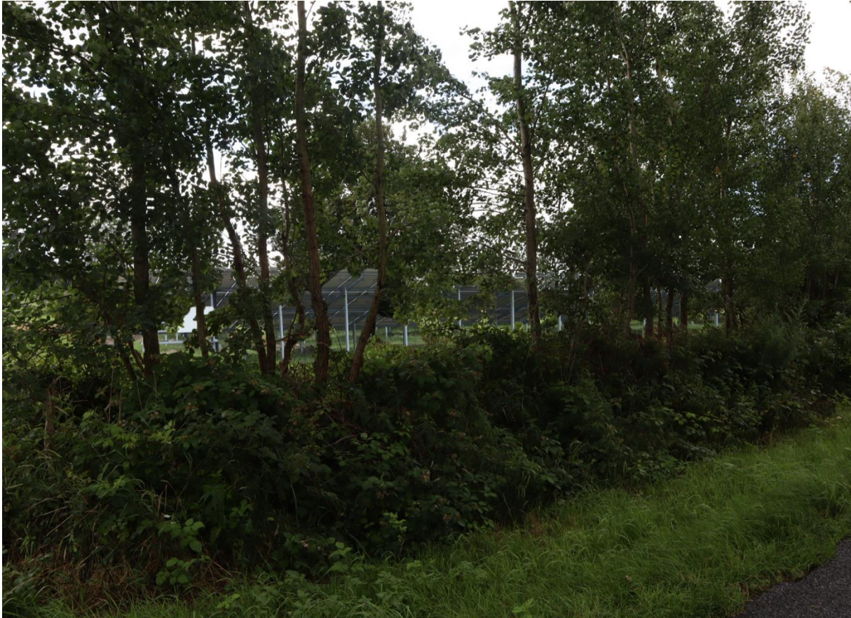
Abb. 8: Fotostandort 2 mit Blickrichtung auf die Freiflächenphotovoltaikanlagen (FF-PVA) (Visualisierung: MaxSolar)
