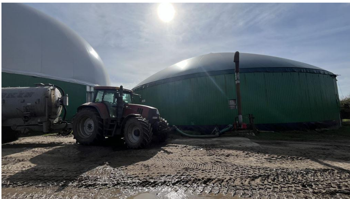
Abbildung 13: Nachgärer und Endlager 1 im südwestlichen Plangebiet, Elbberg 2024.
