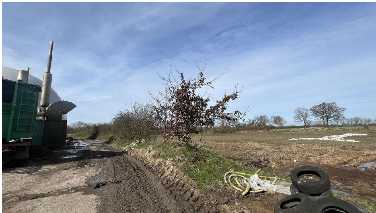
Abbildung 12: Havariewall entlang der nördlichen Grenze des Betriebes zum Acker, Elbberg 2024.
