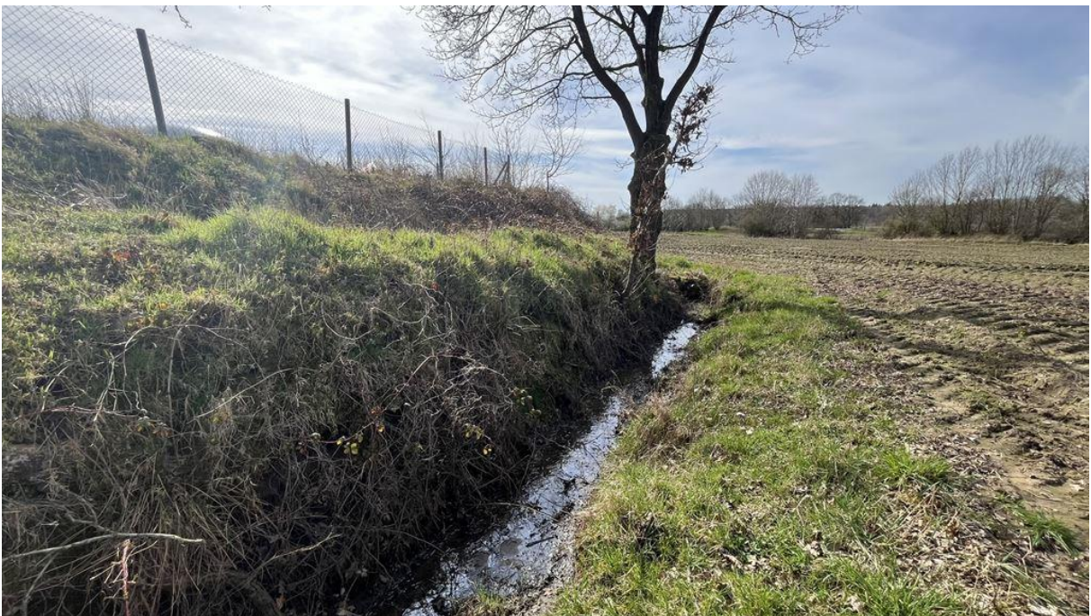
Abbildung 17: Entwässerungsgraben nördlich des Speicherbeckens, Elbberg 2024.
