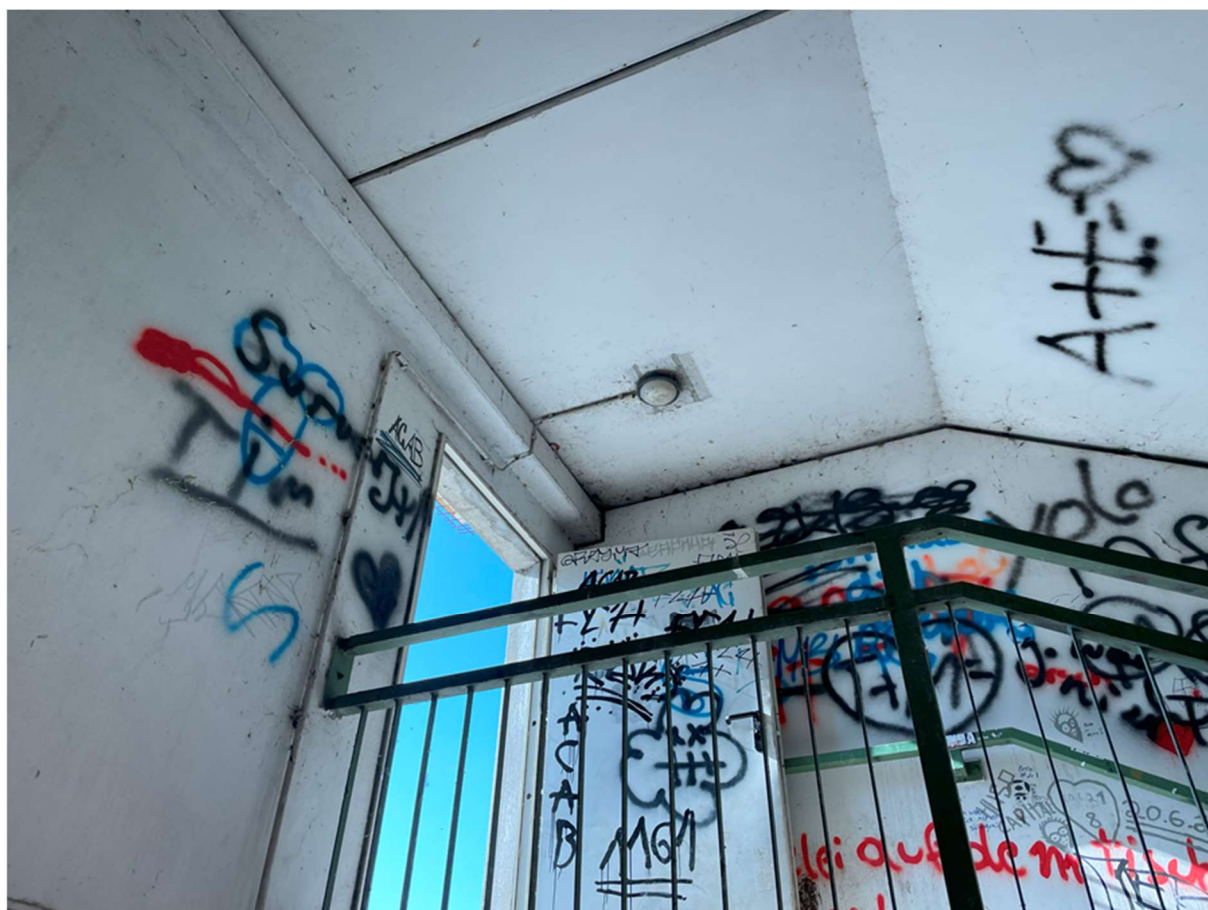
Abbildung 7 Dehnungsfugen nordwestlicher Treppenaufgang der Parkpalette
