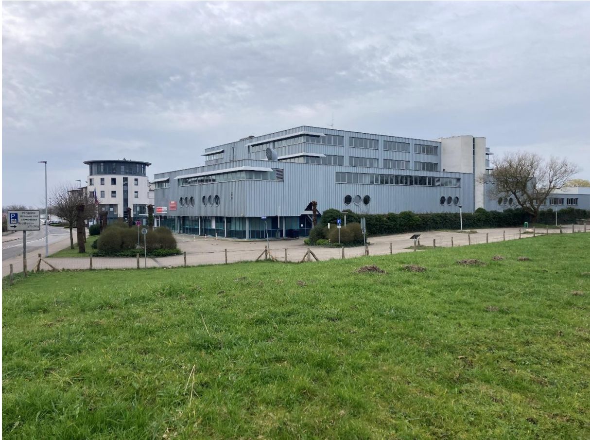
Abbildung 4: Fassade der Bestandsgebäude
