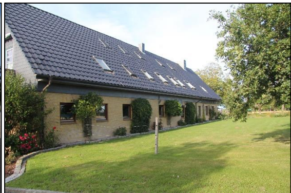
Wohngebäude Ansicht Süd
