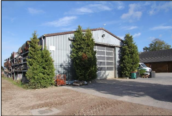
Maschinenhalle Ansicht Ost
