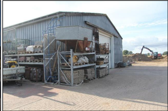
Maschinenhalle Ansicht West mit Lagerregal
