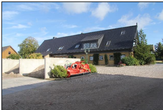
Wohngebäude Ansicht Nord
