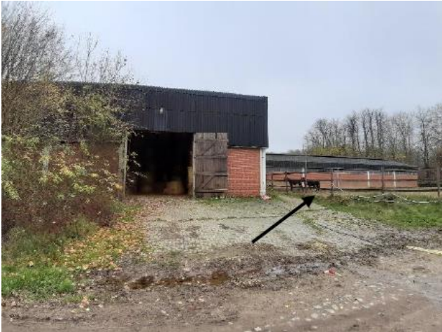
Foto 48: Blick auf Stallgebäude und westlichen Pferdeauslauf
