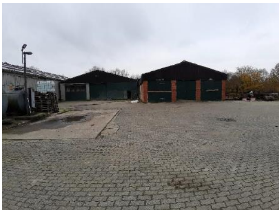
Foto 31: Landwirtschaftliche Anlage mit Hoftankstelle links, Blick Richtung Westen
