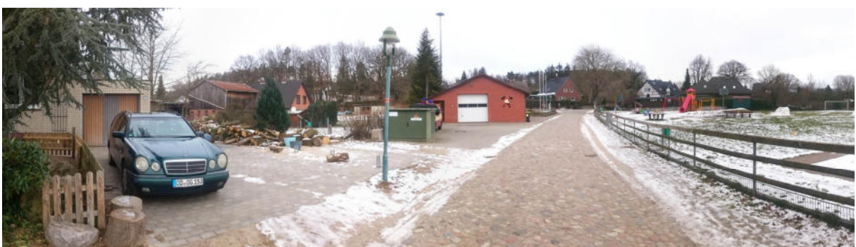
Blickrichtung Nordnordost auf vorhandenes Feuerwehrhaus
