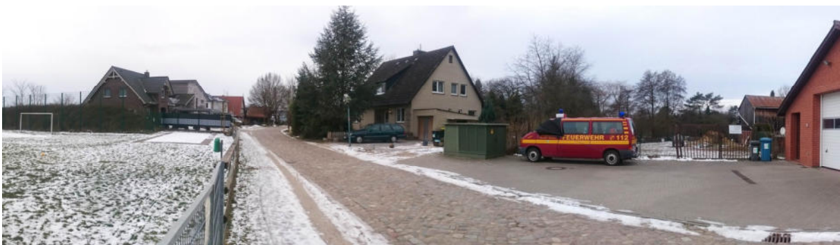
Blickrichtung Südwest auf Gebäude Hofstraße 22 und 11
